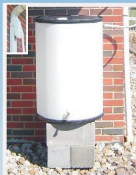
Rain Barrel - 55 gallons
